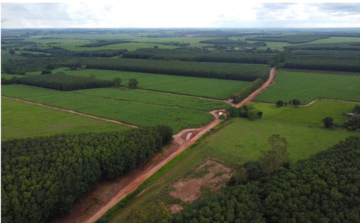
Foto aérea de vicinal tipo II localizada na zona rural do município de Tabapuã/SP.
